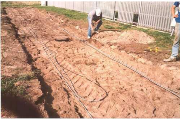
Рис. 3. Гідравлічний засіб виявлення «Ground Perimeter System МРК40»: закладання гідравлічних шлангів, приклади сенсорів та компенсаційних клапанів
